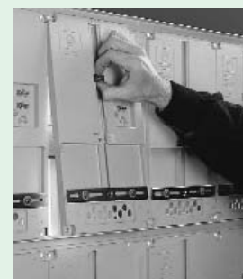
Выдвижение и задвигание панели электрических счетчиков ZBR
